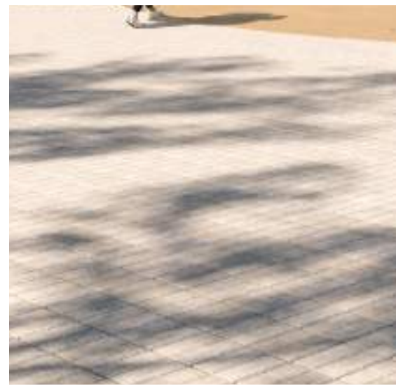
Paviment de llambordes de formigó prefabricat de color gris clar.
